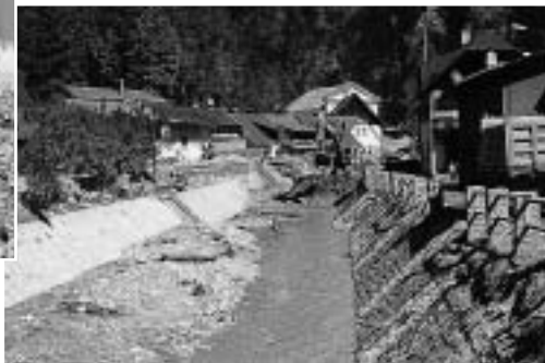
Lavori sul torrente Uque
