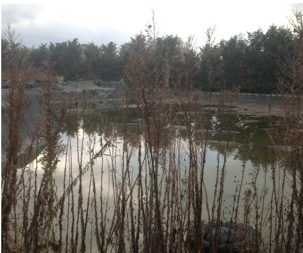
Area con ristagno superficiale di percolato
