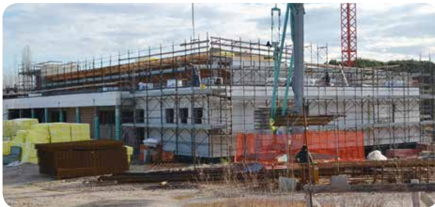
Cantiere Sporting Primavera.
